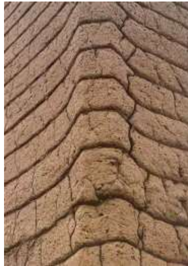
شكل 6: المداميك في واجهات المباني الطينية (مرزوق، 2018).
