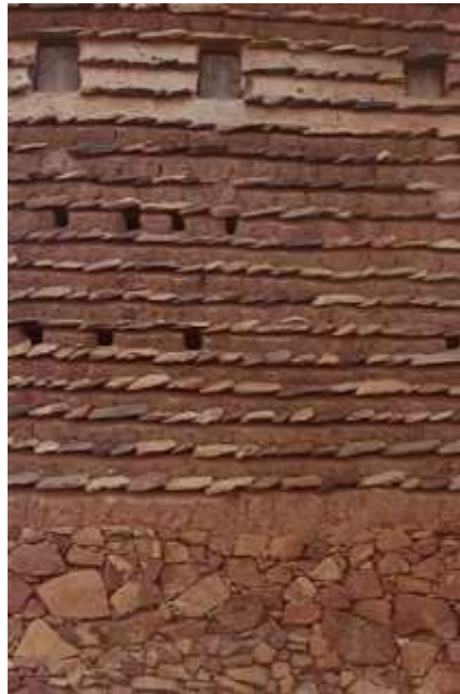
شكل 7: البيوت الطينية الحجرية وظهور طبقات البناء في الواجهة (مرزوق، 2018).
