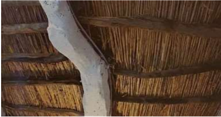
شكل 8: المعدل أو الجايز في سقف الغرفة الداخلية للبيت العسيري (مرزوق، 2018).
