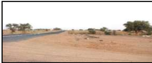
صورة (61) طريق معبد يقطع أحد أودية منطقة الدراسة / المصدر: تصوير الباحث
